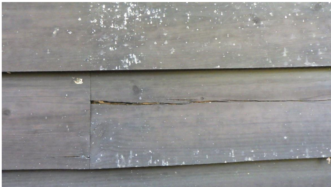
板と板の継ぎ目及びひび割れ部分のシリコン打ち
