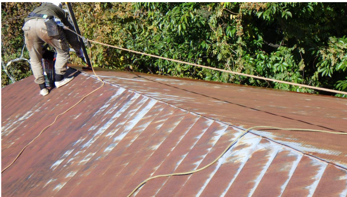
屋根錆止め塗装作業
