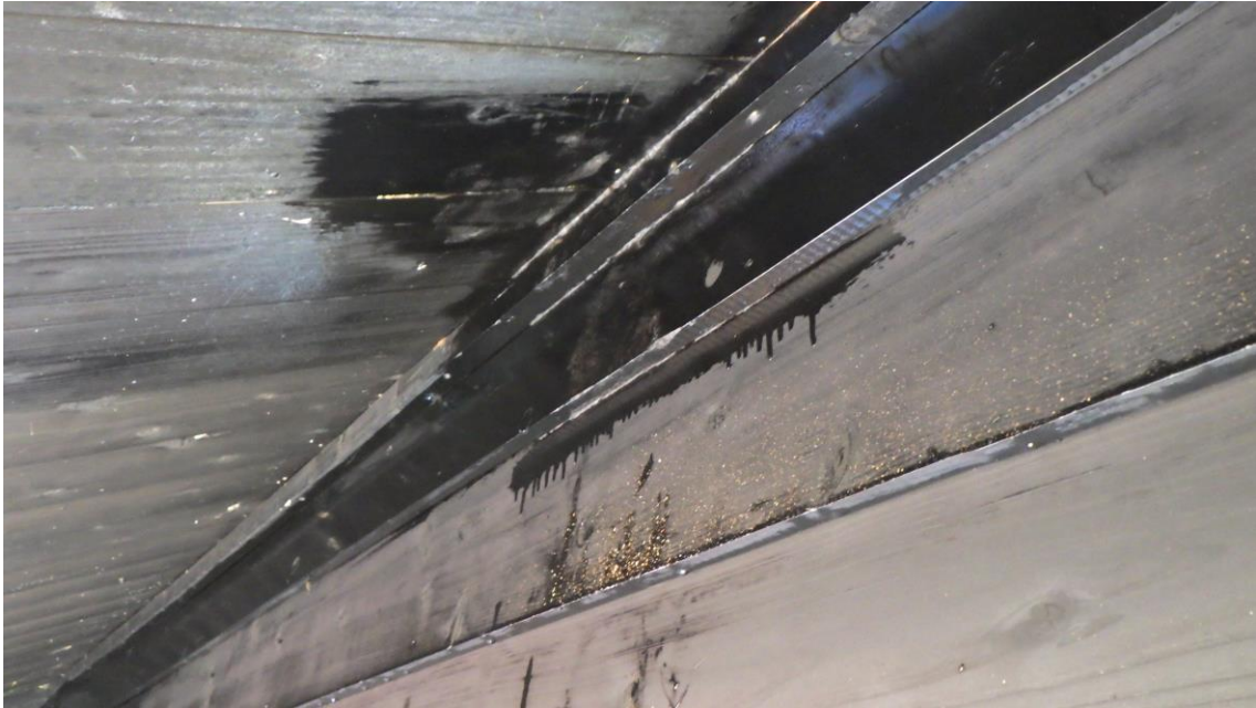
屋根塗装工事
