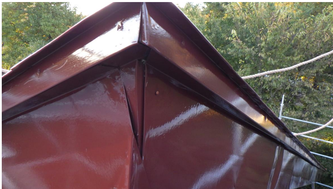
破風鼻隠し・唐草塗装作業
