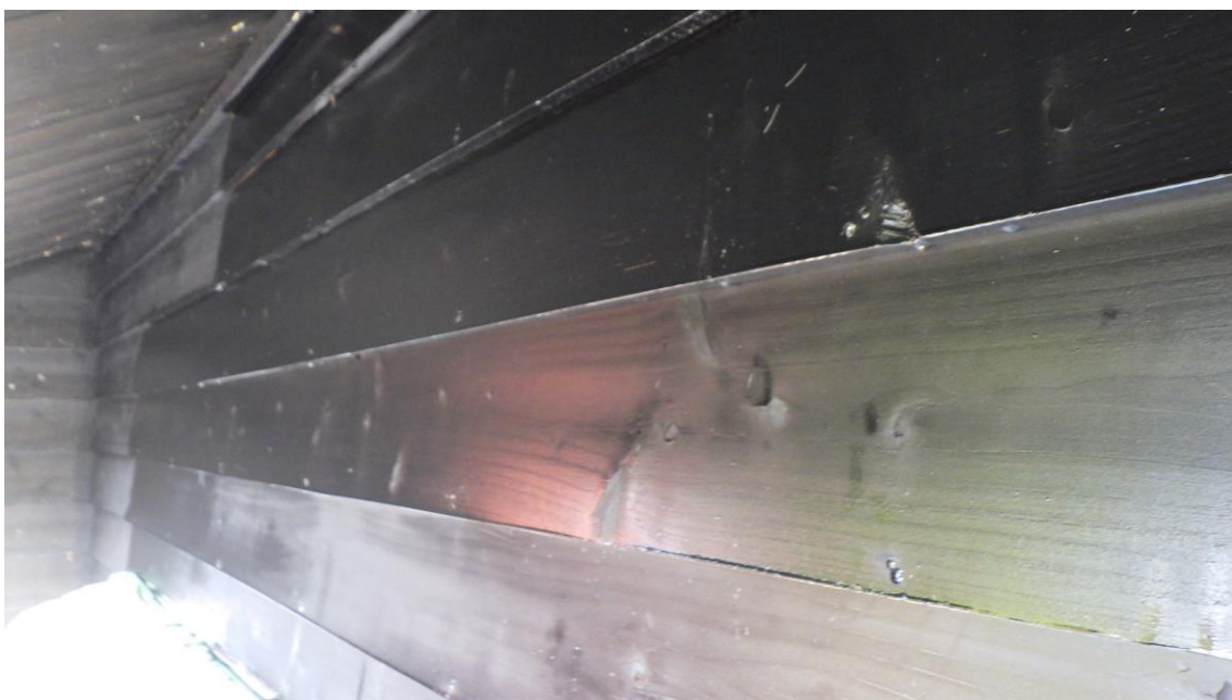
外壁塗装 2回目
