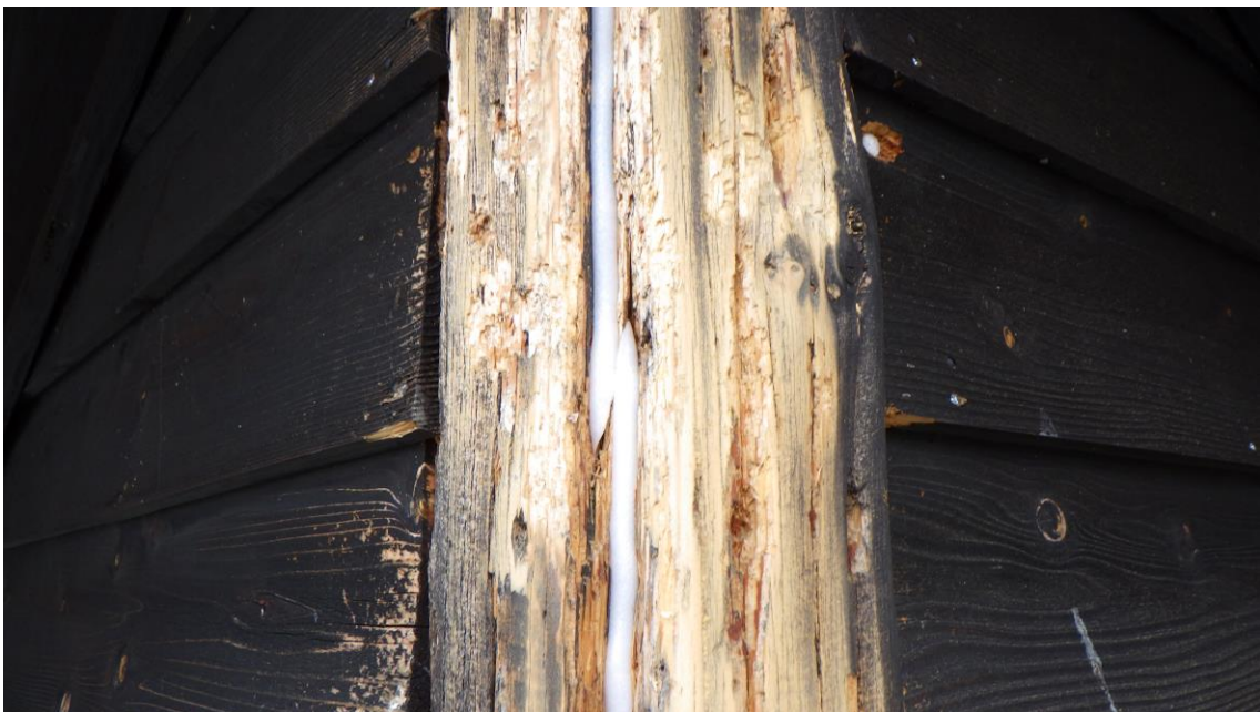
日々や傷の深い部分はバックアップ材を入れます。↑
