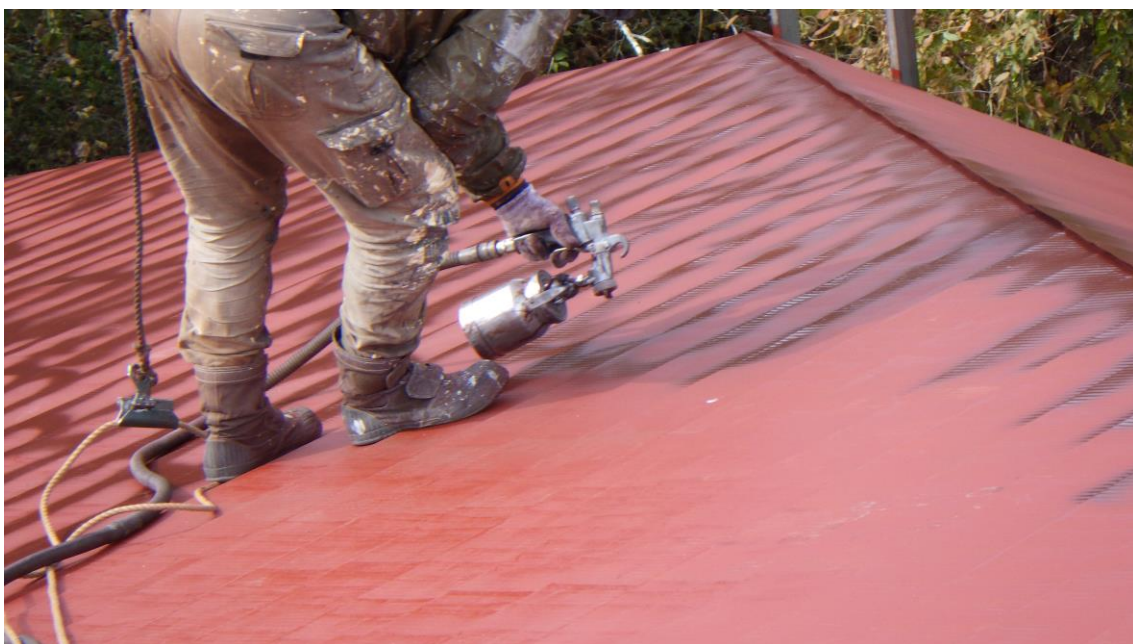
屋根・折り目（つなぎ目）部分の塗装作業
