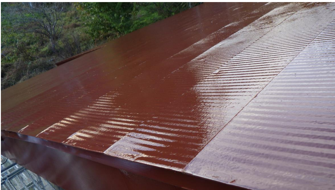
上塗り（仕上げ）塗装作業
